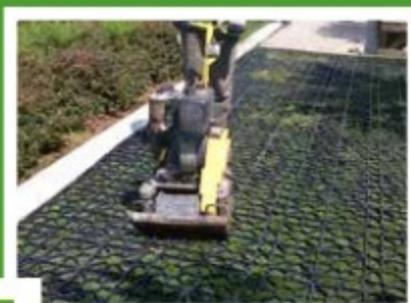
**5** ROULEMENT AVEC ROULEAU MÉCANIQUE ET IRRIGATION
